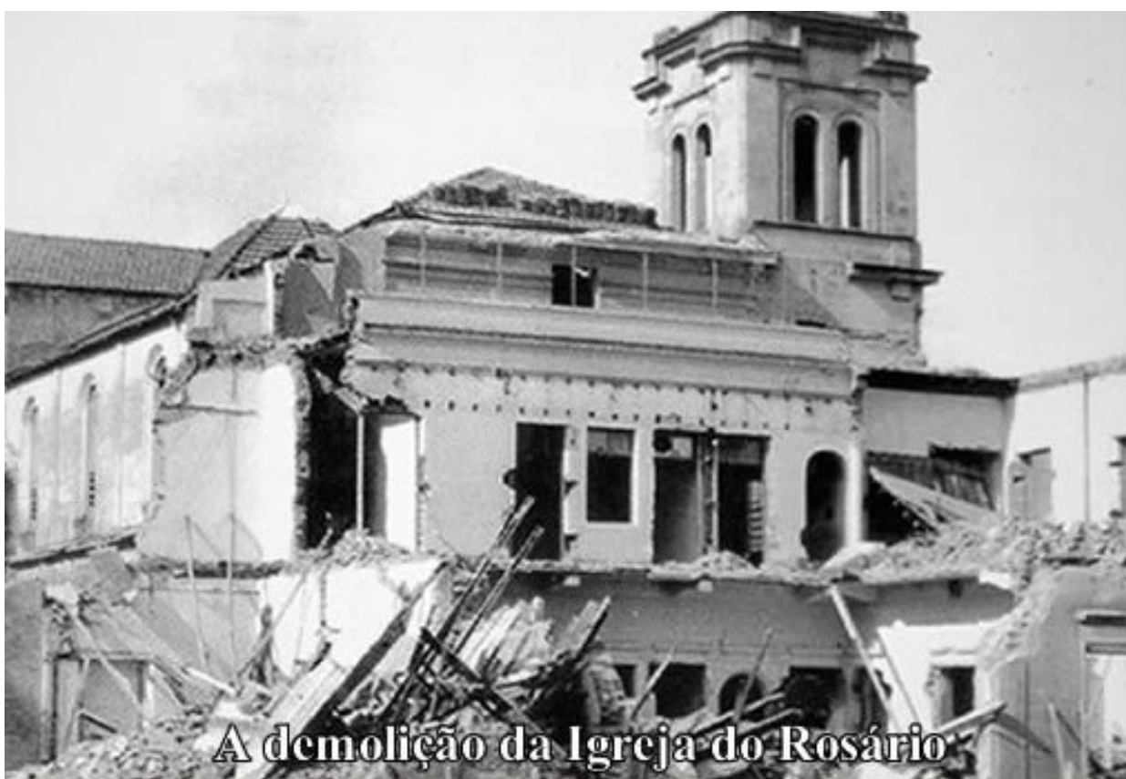
Foto: Demolição da Igreja do Rosário.
